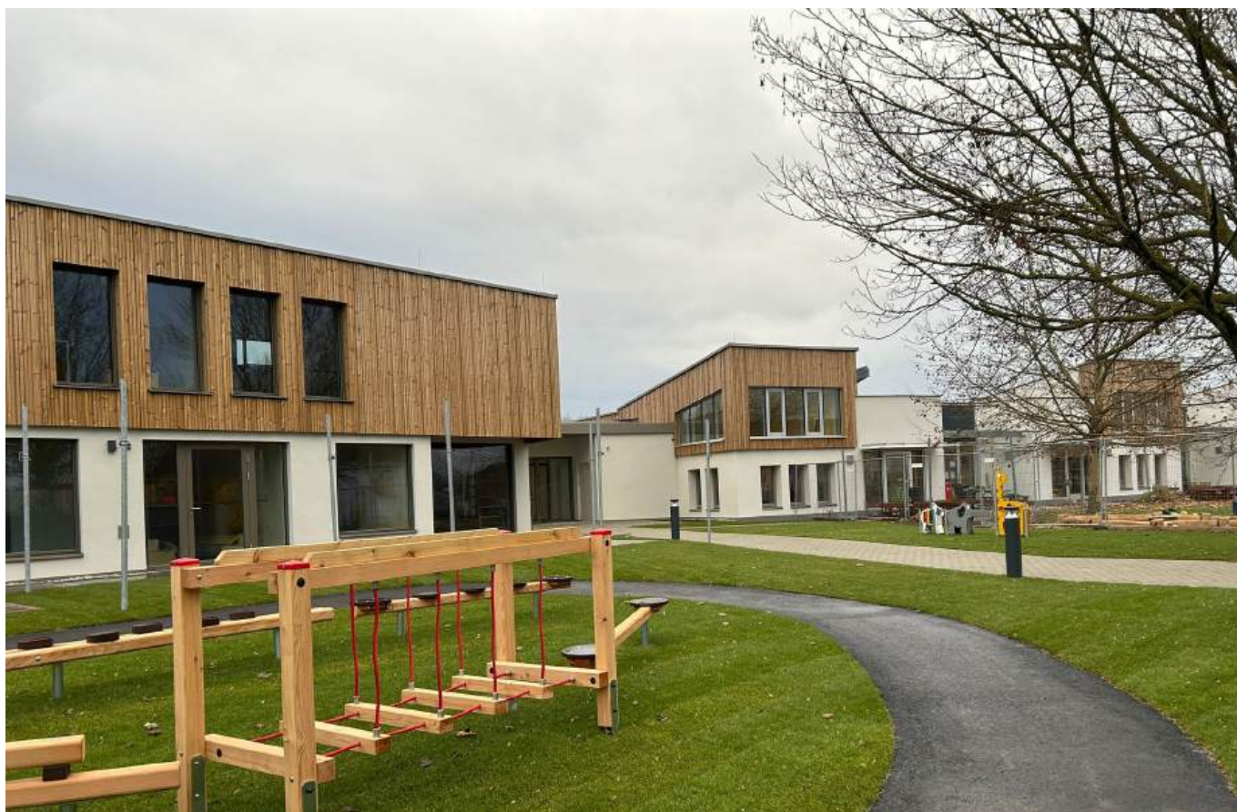
Der Kindergarten Um- und Zubau ging in die Schlussphase Wir konnten den Zubau in einem feierlichen Rahmen am 17.01.2025 eröffnen.
