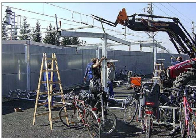
Am Bahnhof wurden die Radständer und die Dachkonstruktion von den Gemeindearbeitern montiert. Das Dach selbst wird nach Ostern folgen. Hergestellt wurde die Konstruktion von den Gemeindearbeitern.
