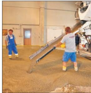
Der Boden in der ASZ-Halle (ca. 250m<sup>2</sup>) erhielt nun einen säuresicheren Betonboden (Fa. Schindler). Somit ist das Niveau der Halle einheitlich. Die Zufahrten werden zum späteren Zeitpunkt ebenso angepasst und neu asphaltiert. Damit ist die Adaptierung des ASZ beendet.
